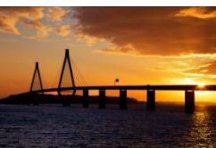
Den gyldne vej til Sydhavsøerne. Farøbroen, Storstrømmen.
